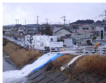
東日本大震災復旧支援(排水作業) (H23.3~H23.5)
