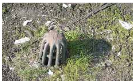
写真3 <土壌が堆積した雨水排水ドレン>
