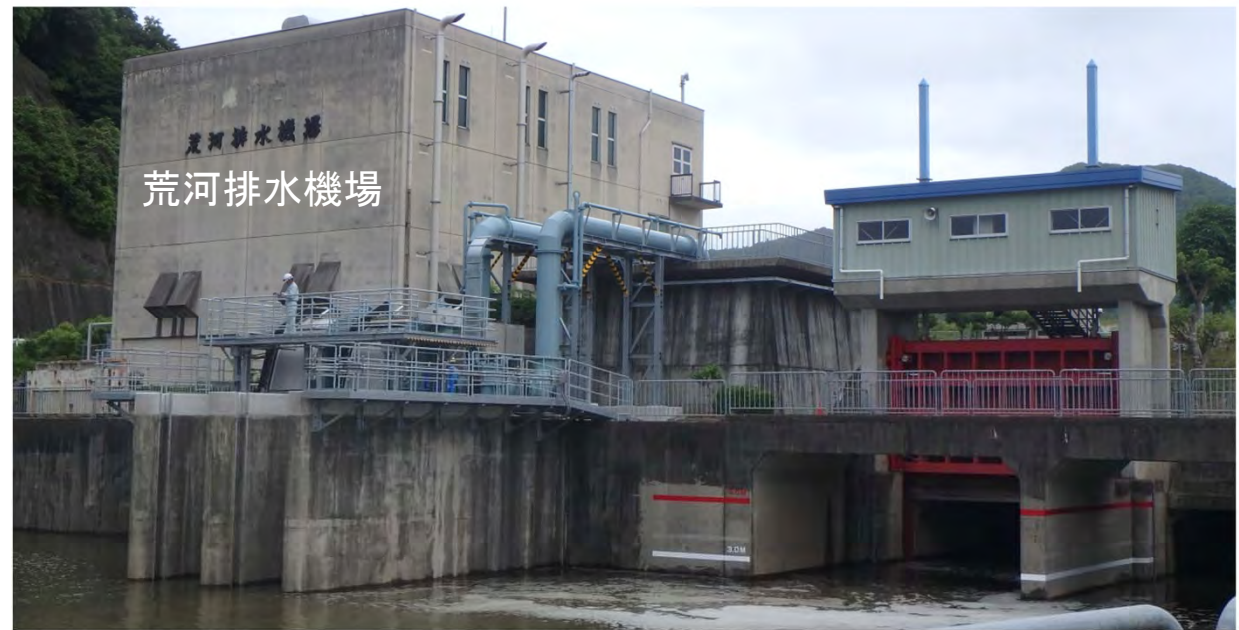
荒河排水機場
