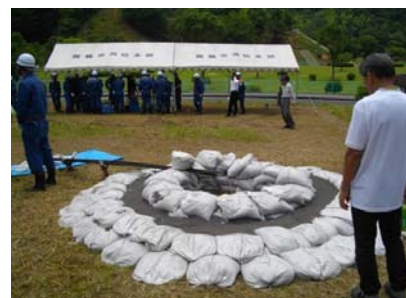
【土のうを用いて釜段工法完了】
