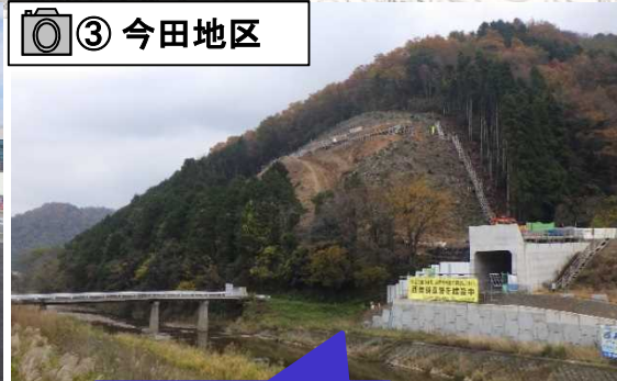
道路を作るため、山を削る作業をしています。
