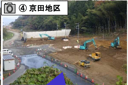
盛土を行って地盤を高くする工事を行っています。
