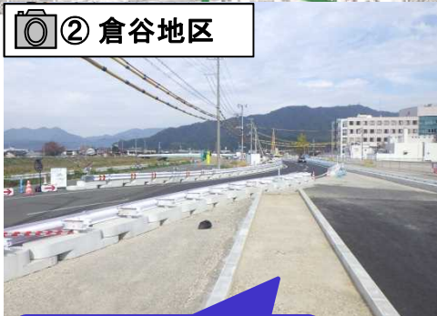
道路を切り回して、水を流すための管を設置しています。
