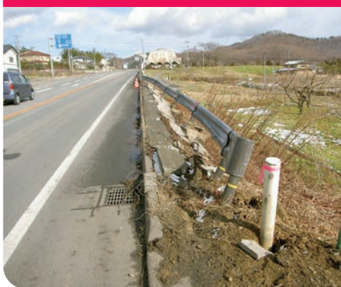
ガードレール・標識等の損傷
