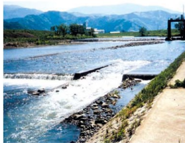
【粗石付斜路式魚道】平成9年度施工
