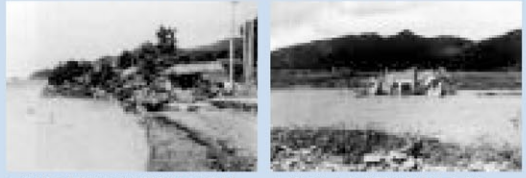
▲北川の氾濫により破壊された家屋 (小浜市西津)
