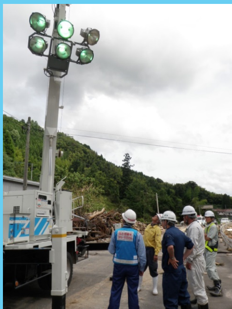
◀災害対策用機械 (照明車) 派遣 (大分県日田市)
