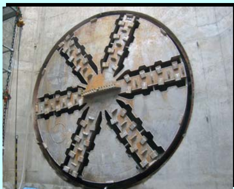
掘削が完了した枚方シールドマシン 面板の状況
