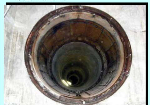
到達立坑よりシールドトンネル （京都方面）を望む
