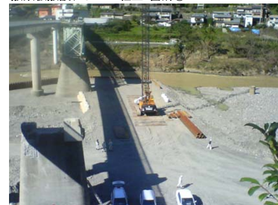
クローラークレーン折立橋右岸ヤードへ移動完了 敷鉄板敷設、ブーム組立<箇所④>
