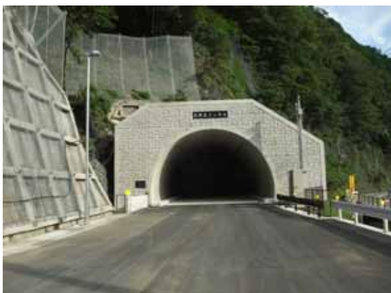
大津呂トンネル（小原出入口側）
