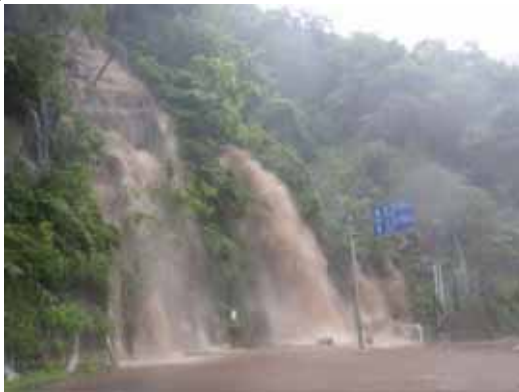
降雨による通行止(H23.7 十津川村折立)
