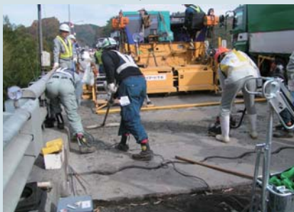
(床版増厚状況)
