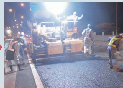
(舗装復旧状況)
