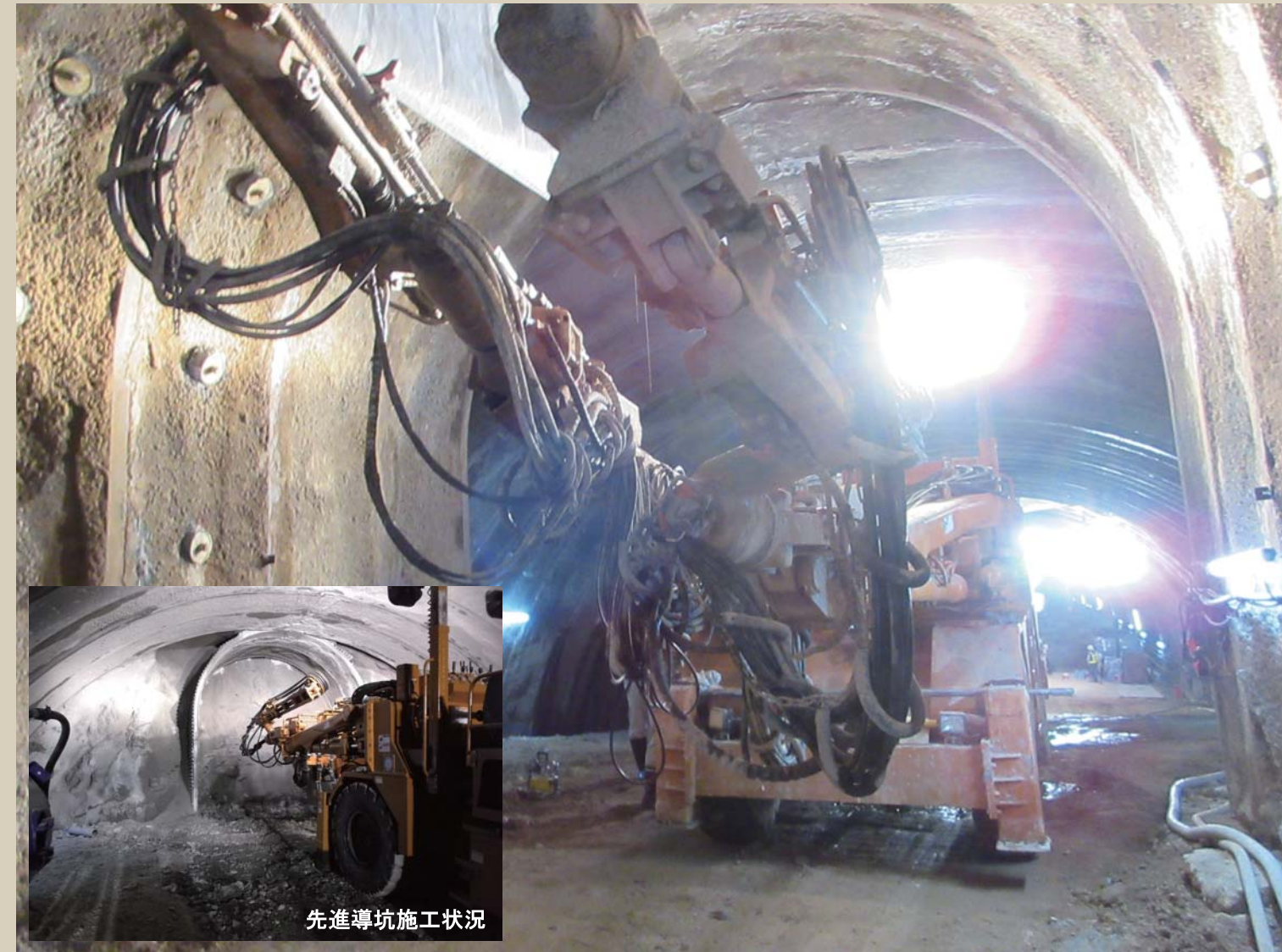
写真：新田東佐味トンネル掘削工事現場の状況 ※構造物名称は仮称です。
