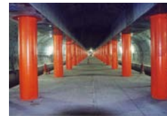
鉄道トンネル
