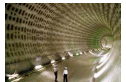
放水路トンネル
