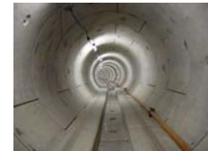
下水道トンネル
