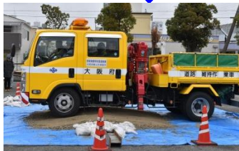
疑似段差設置
