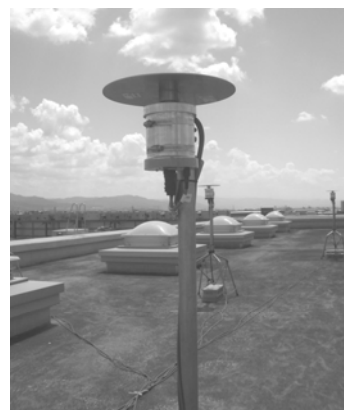
(写真-2) 干渉計設置
