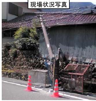
現場状況写真
