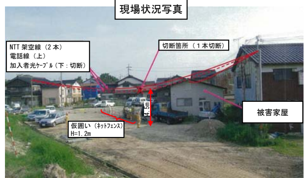
現場状況写真
