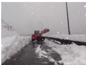
現場状況写真
