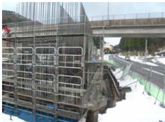
現場状況写真
