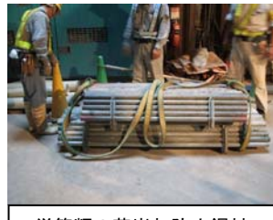
単管類の荷崩れ防止鋼材
