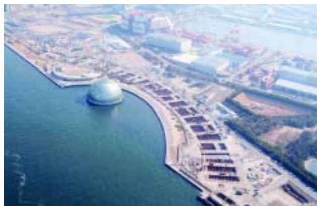
写真 - 2 夢洲トンネル咲洲側アプローチ部全景
