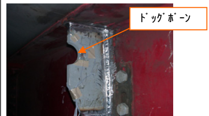
写真 - 3.3.1 垂直補剛材の補修
