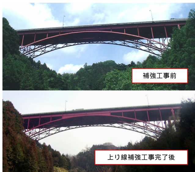
写真 - 1.1 米谷橋全景
