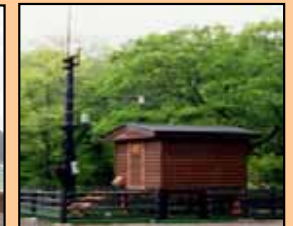
道路気象観測設備
