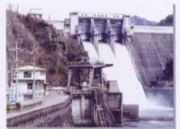
▲ゲート放流状況
