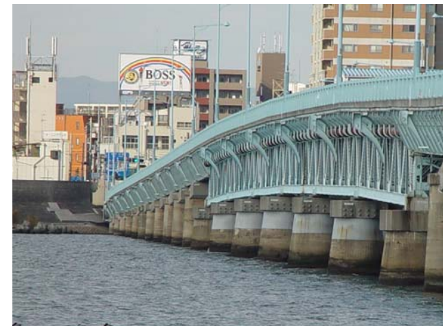
堤防に食い込む 国道2号淀川大橋
