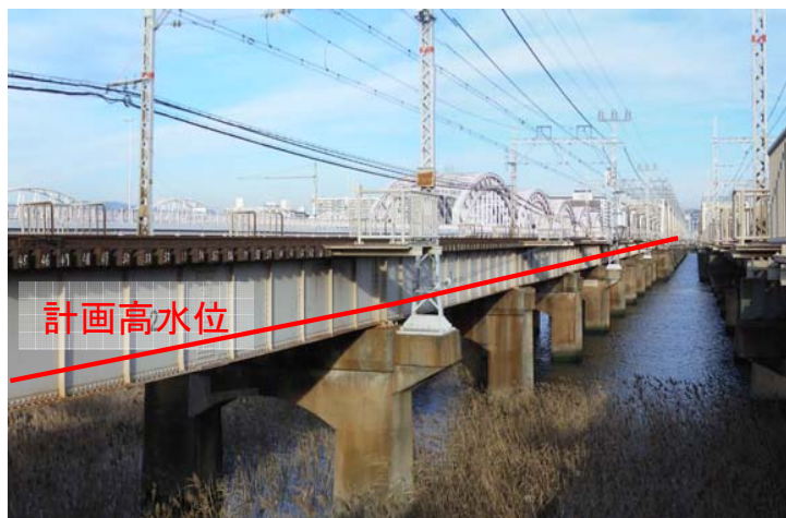
阪急神戸線淀川橋梁
