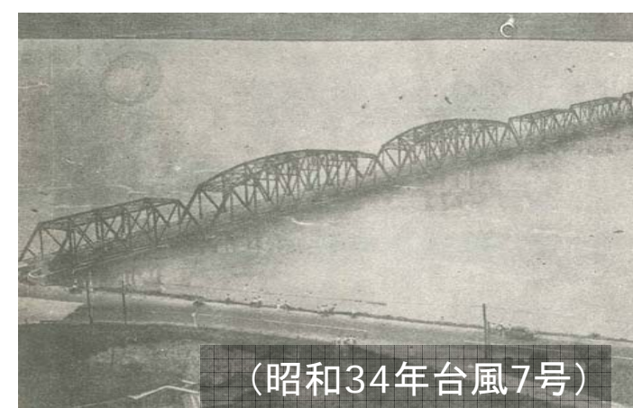
洪水が橋桁にぶつかっている枚方大橋
