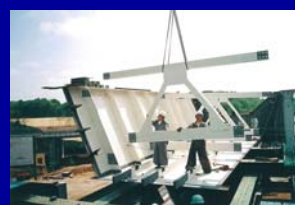
現場でのパネル組立て状況
