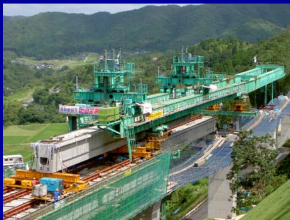
第二戸奈瀬高架橋
