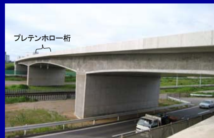
多々羅田橋梁(径間部はプレテンホロー桁)
