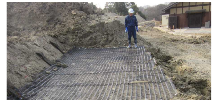
盛土補強材の設置状況
