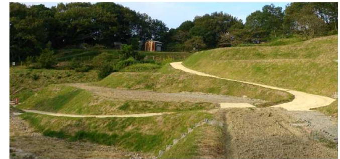
盛土補強により再生した棚田景観（代ヶ谷棚田）
