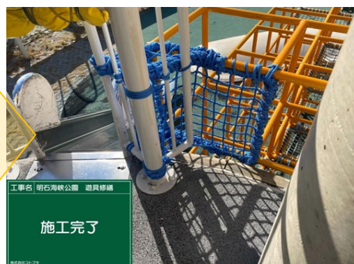
子供の森（ジャングルジム安全措施） 頭部胴体首挟み込み防止ネット設置
