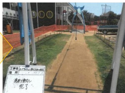
夢っこランド（ロープウェイ下マット反り返り） ゴムマット撤去→真砂土舗装
