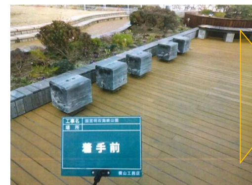
海のテラス（椅子腐食）椅子撤去→新規設置
