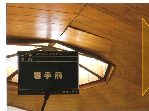
レストラン花屋敷（天井剥がれ）天板補強
