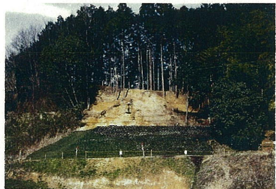
南側斜面応急対策後(南から)
