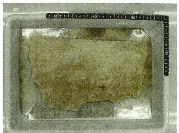
取り外した漆喰片(天井)
