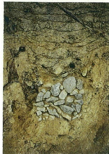
南側斜面 暗渠排水溝(南から)
