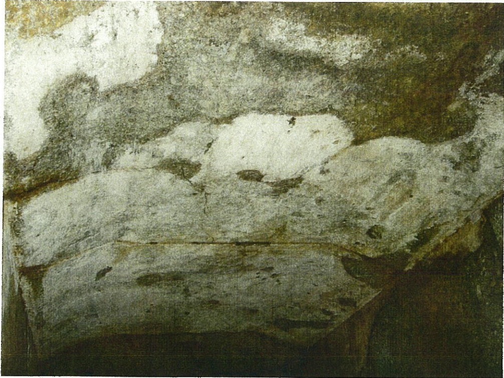
天井取り外し終了後
