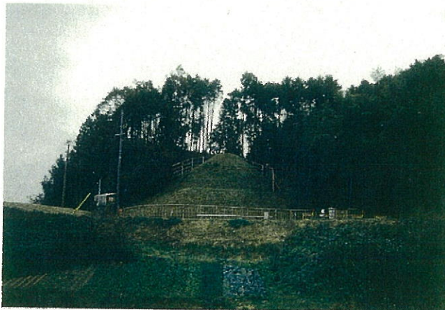
墳丘応急対策後(南から)
