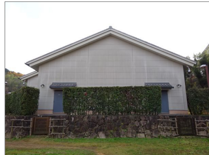
平成21年に設置された壁画保存管理修理施設（仮設）
