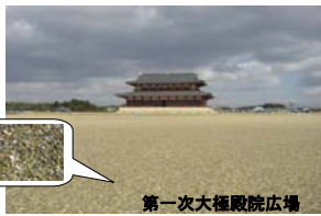
特殊開粒度アスコン+砂利転圧(t=60) 砕石路盤(t=150)
