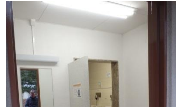
トイレ棟の明るさの改善
