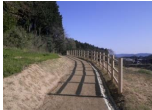
転落防止柵の修繕
