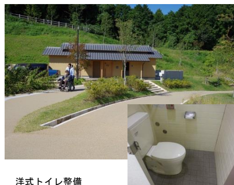
洋式トイレ整備
