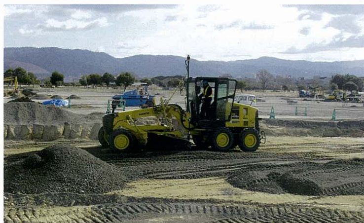
モーターグレーダーによるマシンコントロールを用いた路盤整正
