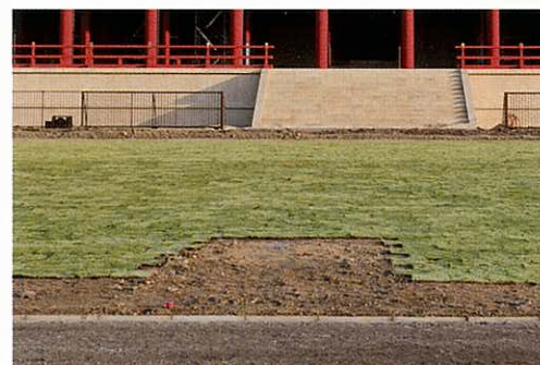
セン積擁壁や回廊基壇は復原せず、芝張りを実施
