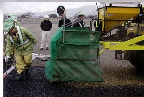
透水性のある玉砂利を用いた表面舗装を実施
