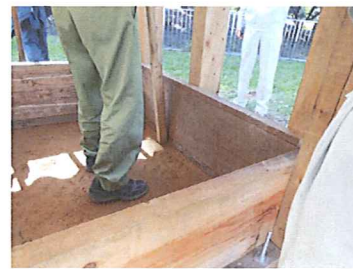
型枠際の突き固め(特殊な搗き棒)
