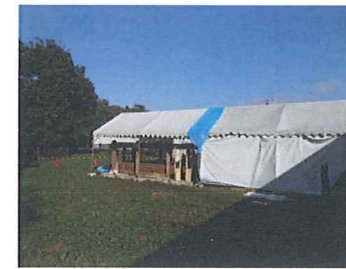
テント設置全景
