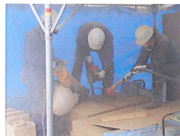
ダイヤモンドチェーンソーによる切断
