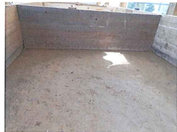
最終段階でタコで仕上げる
