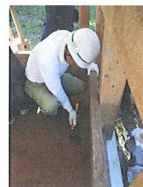
鋼製カマによる打継 高さ決め作業
