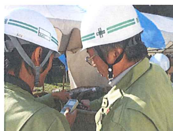
攪拌土の含水率測定(各バッチ毎)
