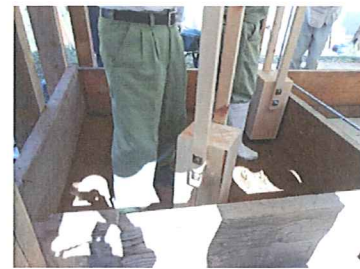
タコによる均し
