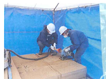
ダイヤモンドソーによる切断
