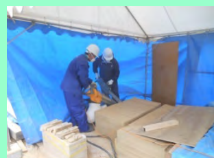
ダイヤモンドチェンソーによる切断
