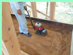
機械化施工試験 （小型ランマー）
