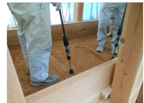
手持ち式サンドランマー施工状況
