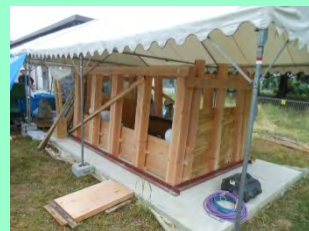
版築施工用型枠
