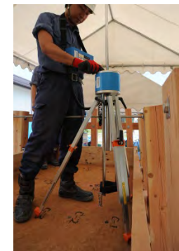
簡易支持力試験による強度管理
