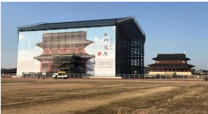
【南門復原整備工事の素屋根（手前）】
