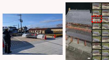
ドローンによる点検イメージ
