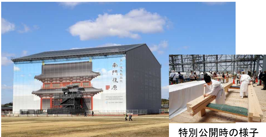
【南門復原整備工事の素屋根】
