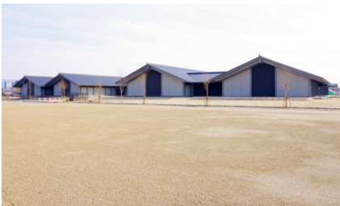
平城宮いざない館(外観)
