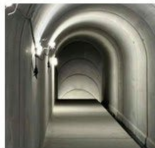
③ ダム内部（監査廊） 右岸入口→左岸出口
