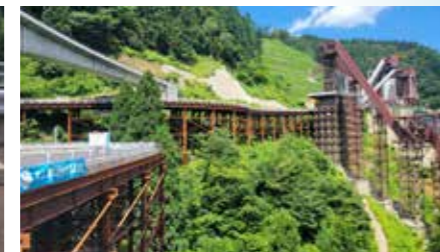
付替県道7号橋
