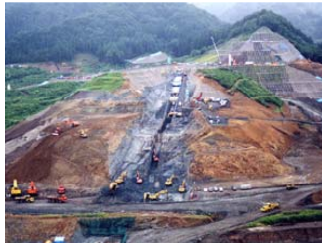
基礎掘削（他ダム事例）
