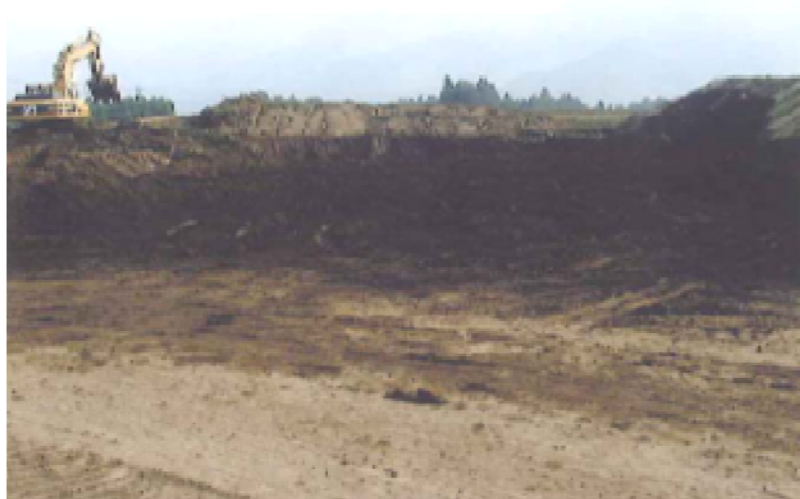
建設発生土処理（他ダム事例）
