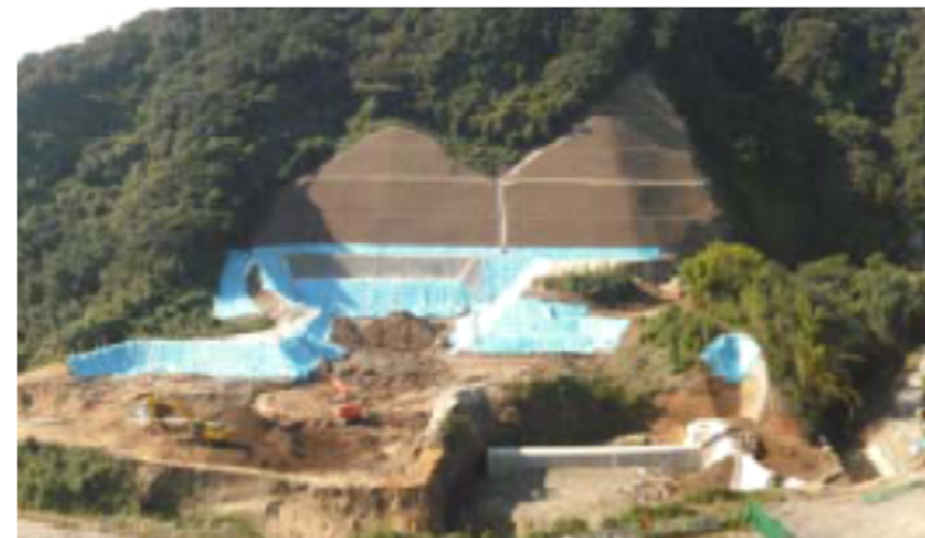
法面工（他ダム事例）
