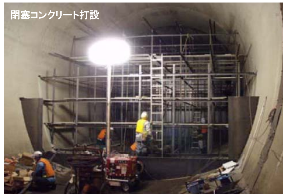
転流工閉塞状況写真（他ダム事例）
