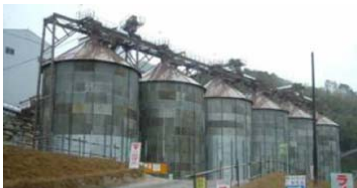
骨材設備写真（他ダム事例）
