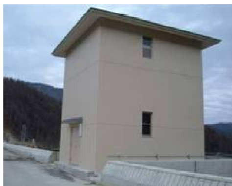
昇降設備写真（他ダム事例）
