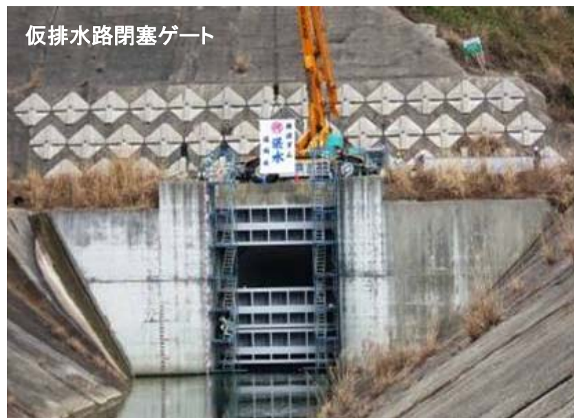
転流工閉塞状況写真（他ダム事例）
