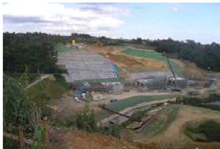
法面工（他ダム事例）
