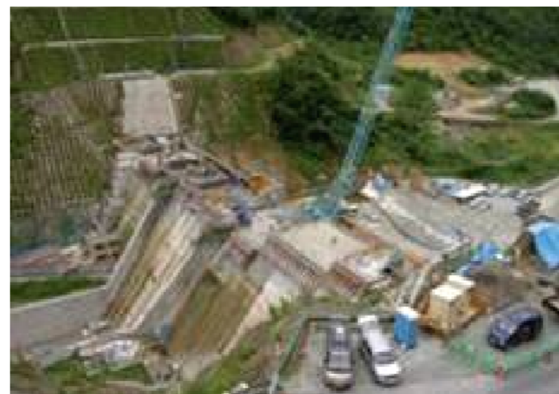
堤体工（他ダム事例）
