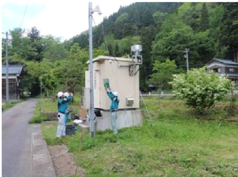
雨量観測所写真（設置状況写真）
