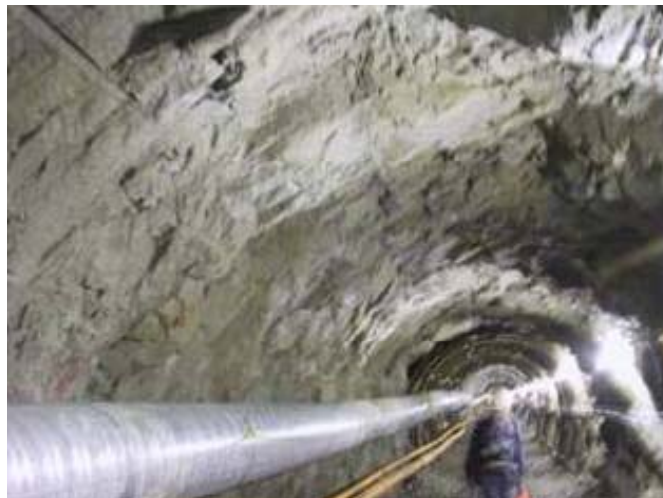
トンネル掘削（他事例）
