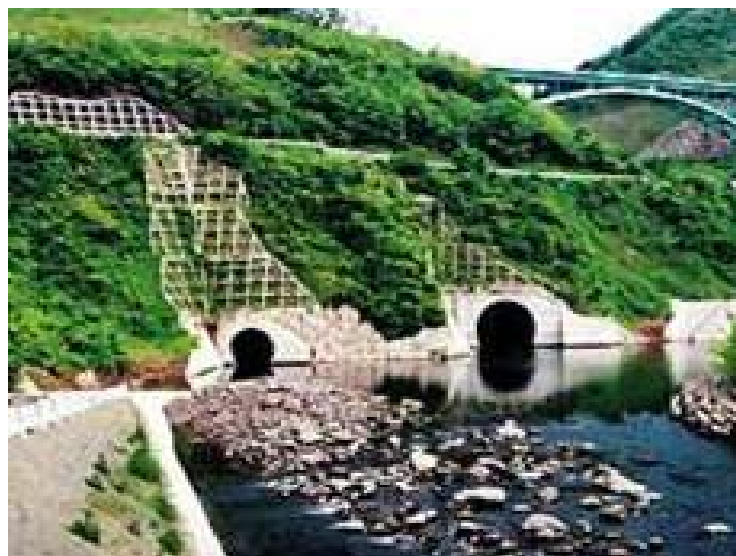
仮排水トンネル（他ダム事例）
