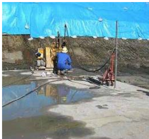
グラウチング状況（他ダム事例）
