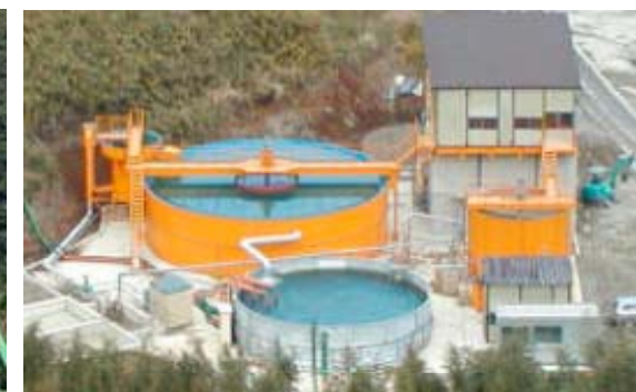
濁水処理施設（他ダム事例）
