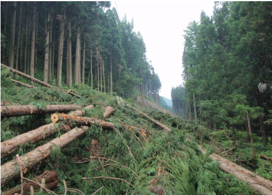
工事用道路施工箇所
