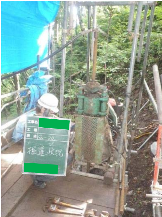
ボーリング調査実施状況
