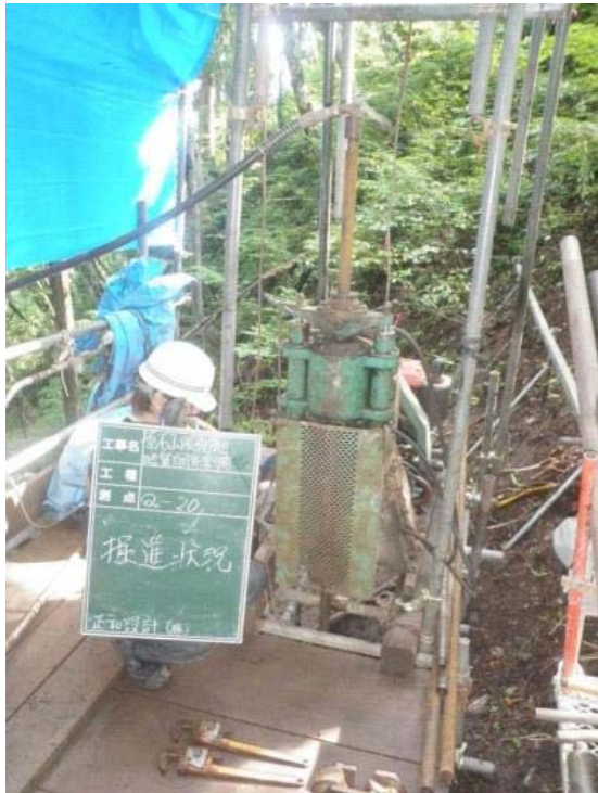
ボーリング調査実施状況
