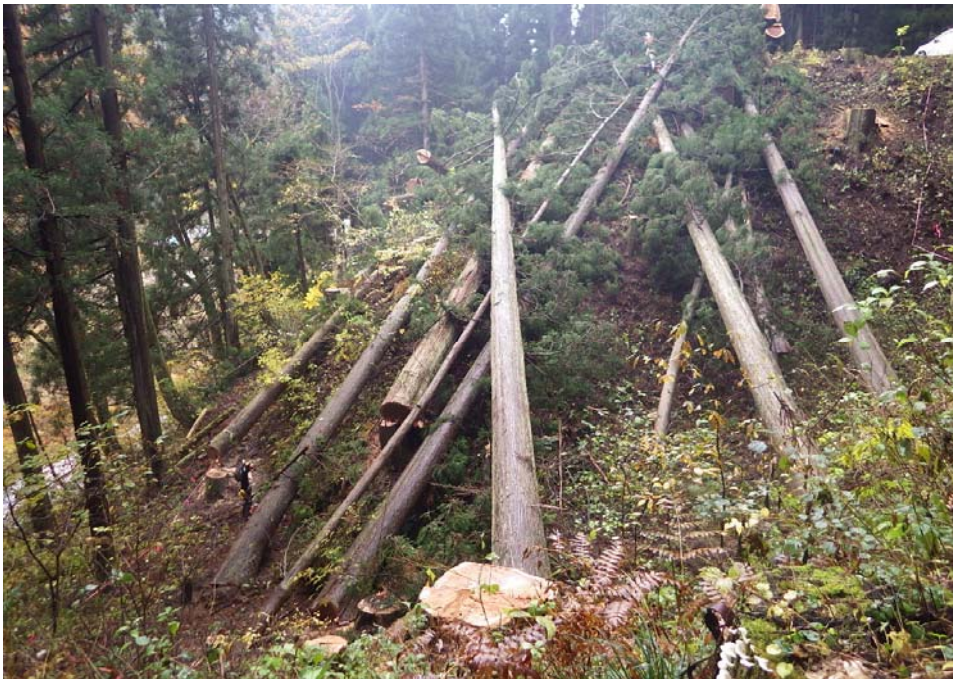
工事用道路施工箇所
