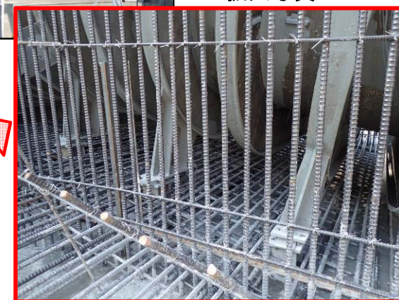
補強鉄筋 拡大写真
