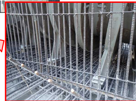
補強鉄筋 拡大写真
