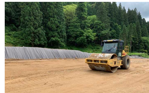
ICTローラー(マシンガイダンス)による転圧管理
