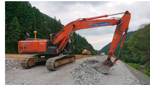
ICTバックホウ(マシンガイダンス)による法面整形
