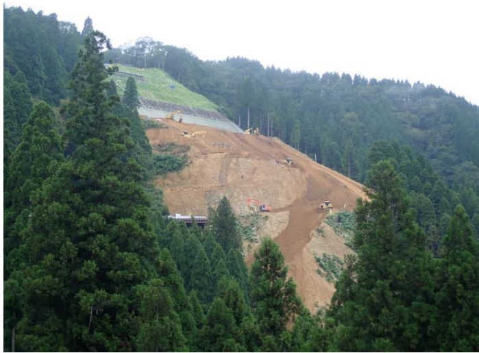
[1]付替県道3工区工事
