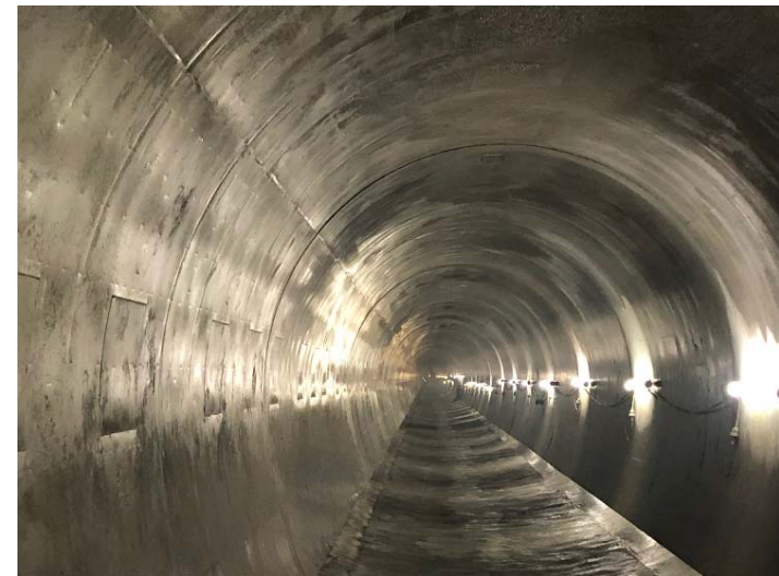
[7]足羽川ダム転流工事
