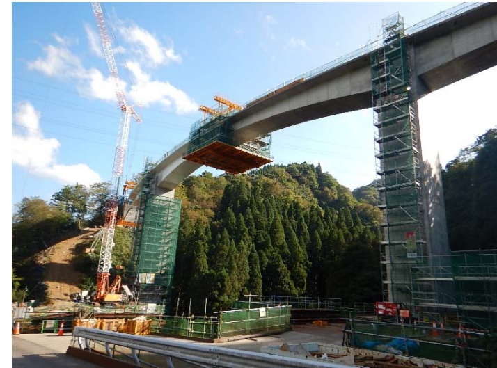
[3]付替県道8号橋工事
