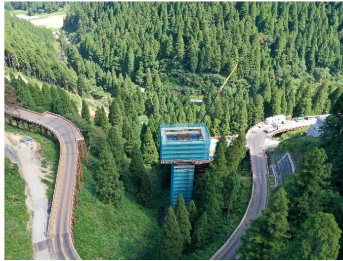
[9]付替県道7号橋上部工事
