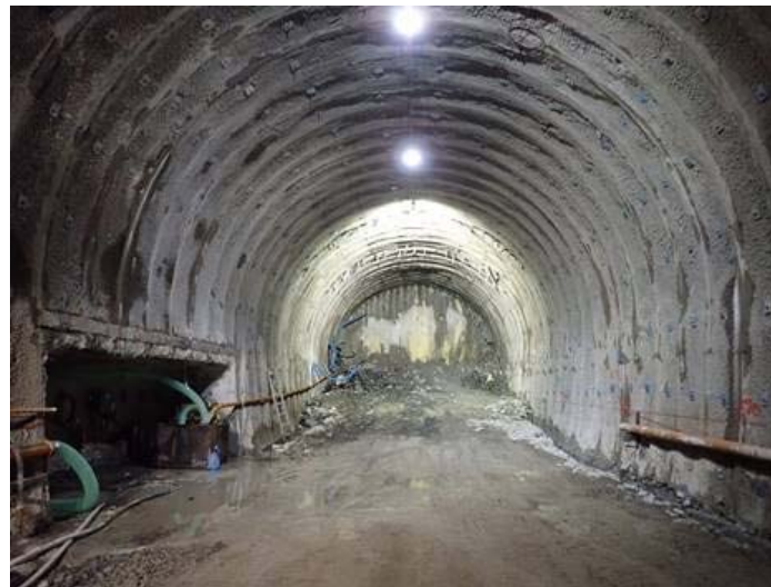
[5]水海川導水トンネル I 期工事
