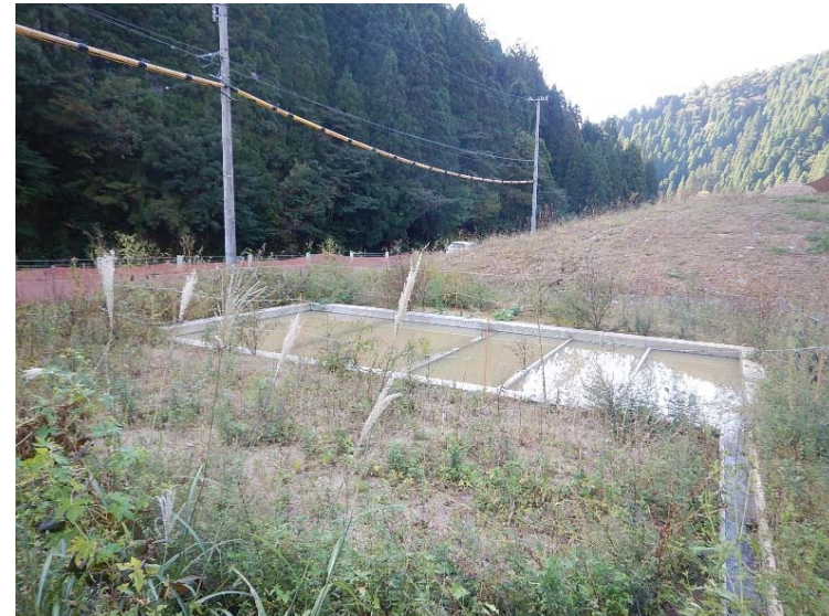
沈砂池＋排水路
