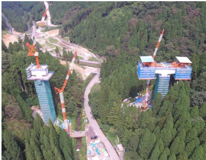
[2]付替県道11号橋工事
