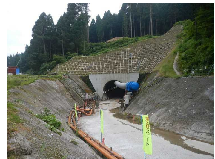
[3]水海川導水トンネルⅠ期工事
