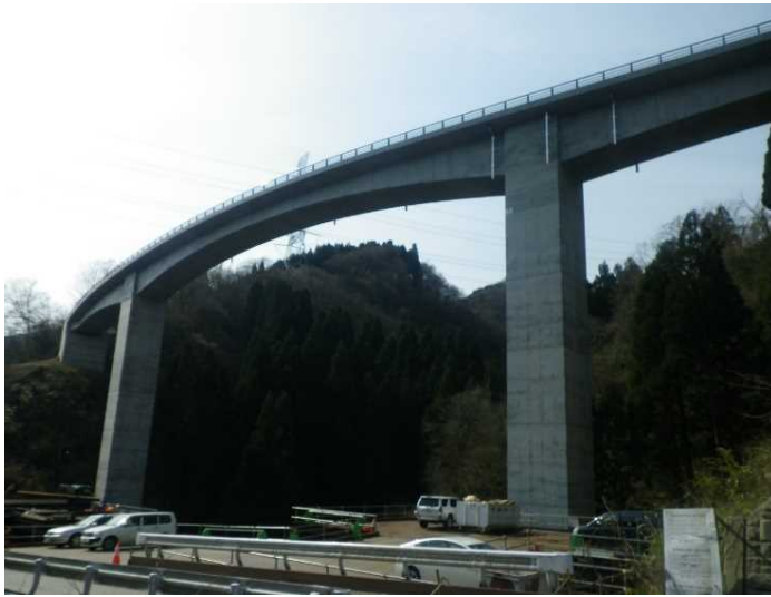
[1]付替県道8号橋工事
