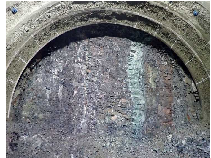
[3]水海川導水トンネル I 期工事
