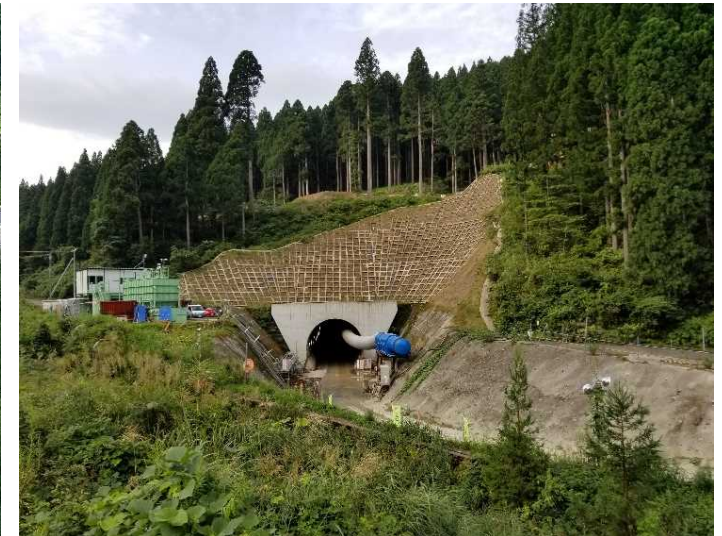
[4]水海川導水トンネル2期工事
