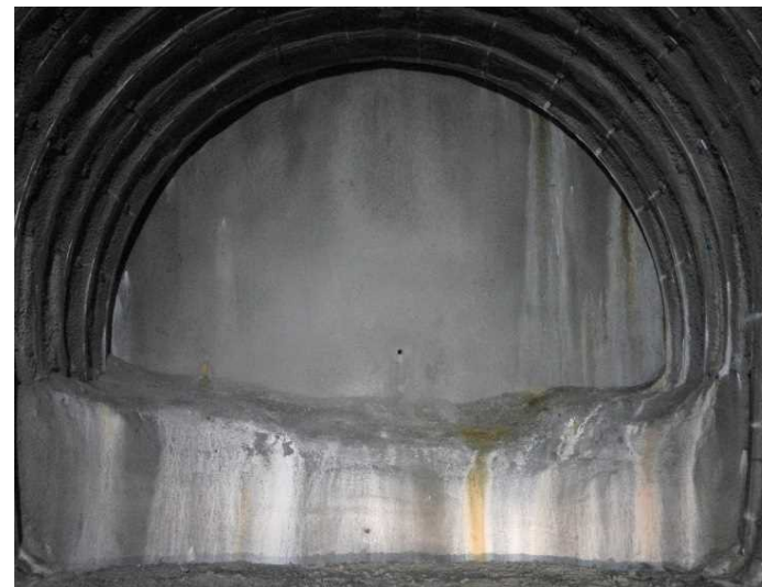
[3]水海川導水トンネルⅠ期工事
