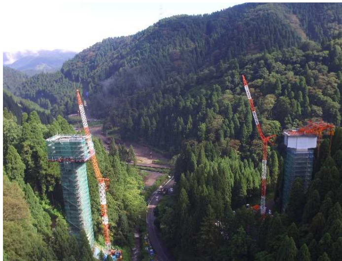
[2]付替県道11号橋工事
