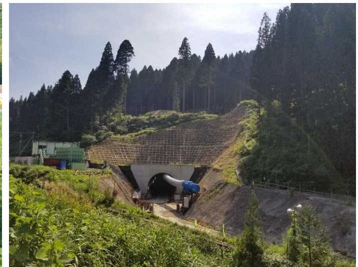
[4]水海川導水トンネル2期工事
