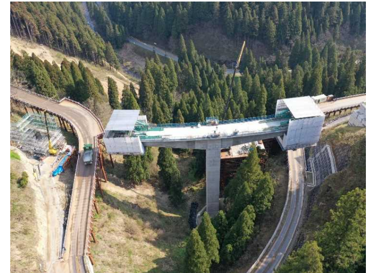
[5]付替県道7号橋上部工事
