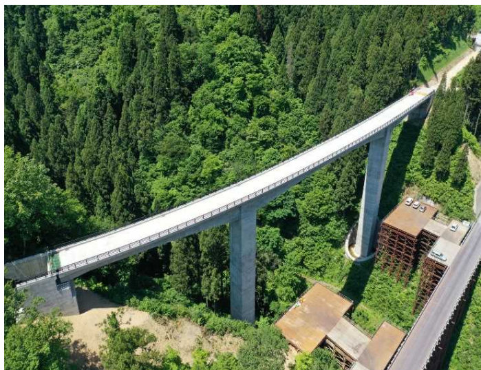
[1]付替県道8号橋工事(完了)
