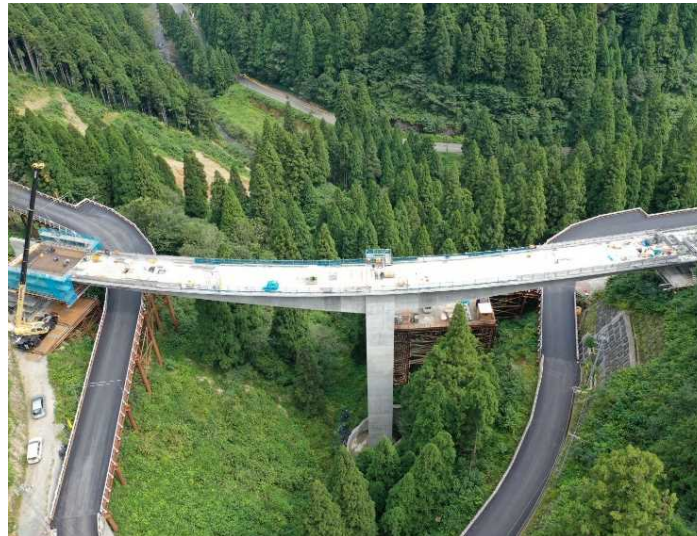
[5]付替県道7号橋上部工事
