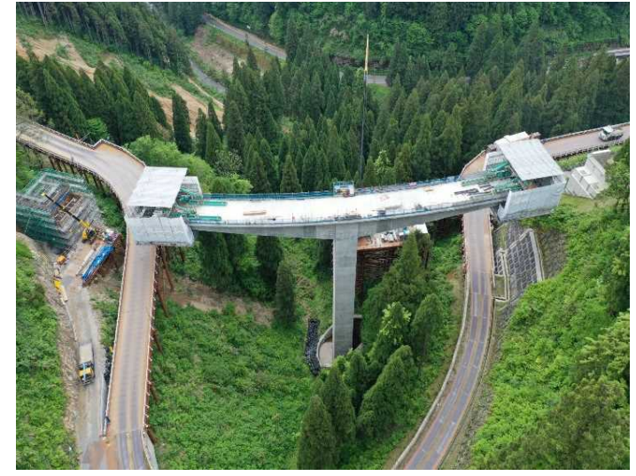
[5]付替県道7号橋上部工事
