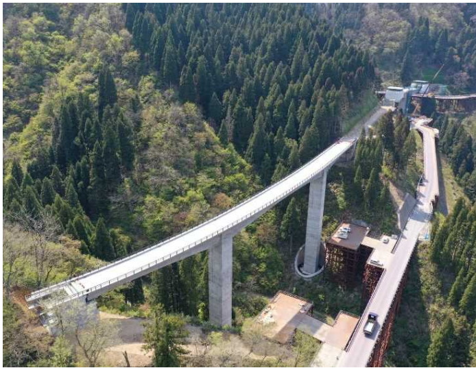
[1]付替県道8号橋工事
