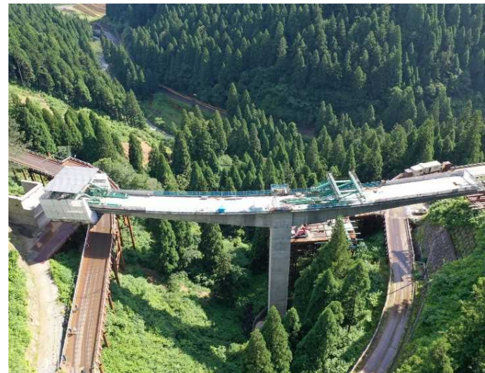
[5]付替県道7号橋上部工事
