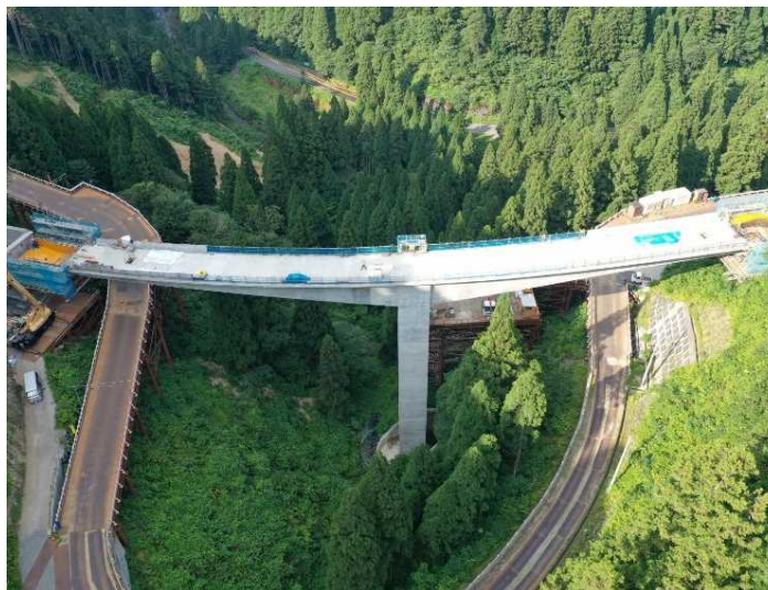
[5]付替県道7号橋上部工事
