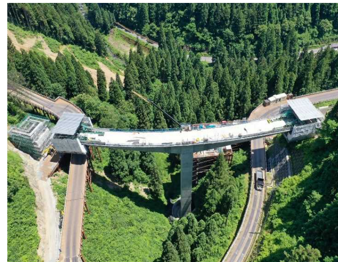
[5]付替県道7号橋上部工事
