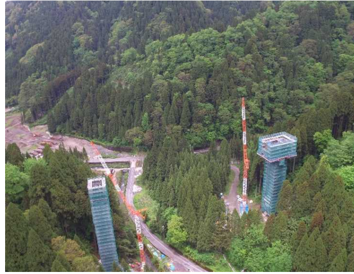
[2]付替県道11号橋工事
