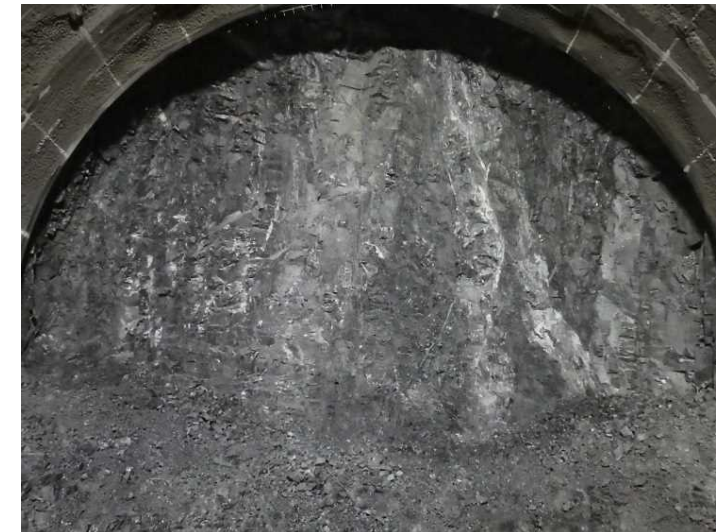
[3]水海川導水トンネル I 期工事
