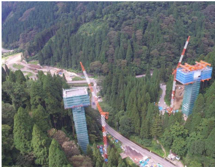
[2]付替県道11号橋工事
