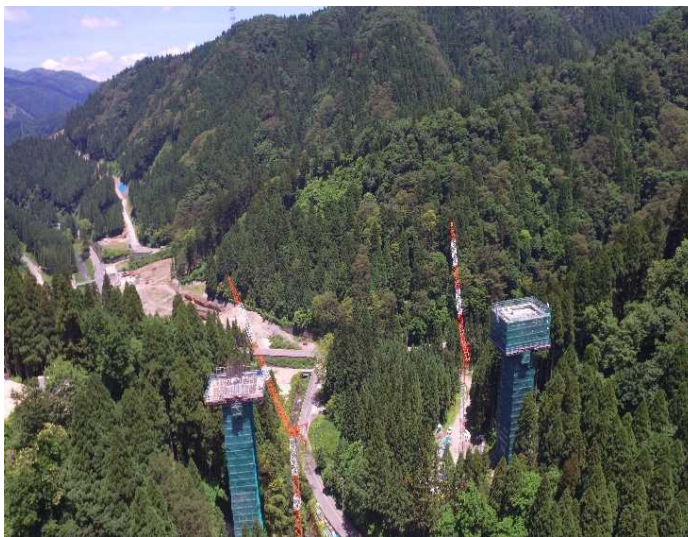
[2]付替県道11号橋工事
