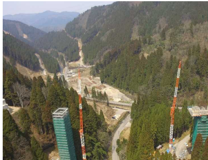
[2]付替県道11号橋工事
