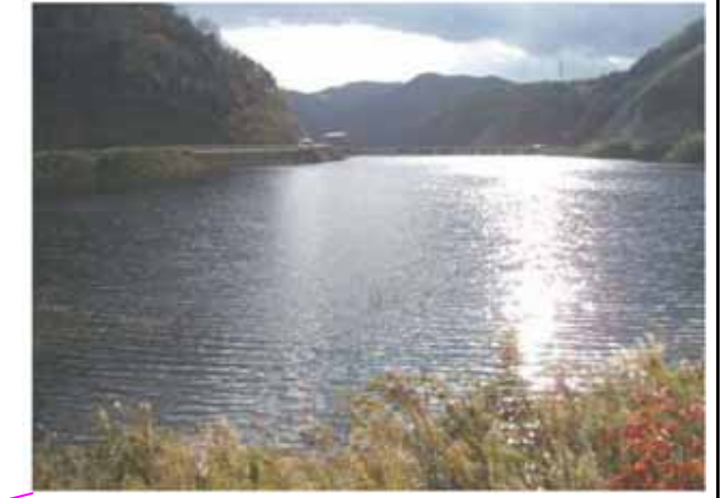
サーチャージ水位EL72.7(H17. 12. 7)
