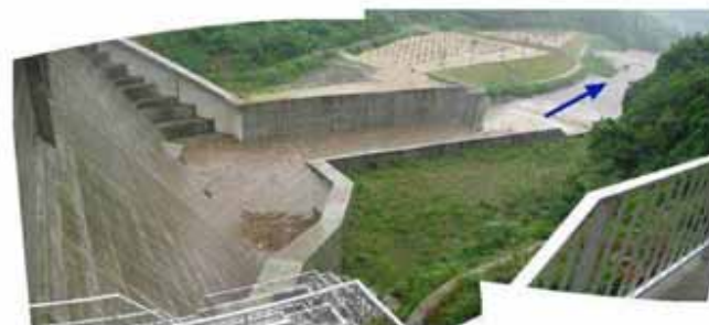
【ダム下流側 減勢工】
