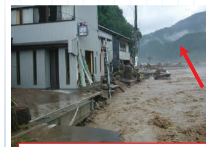
護岸と道路が流失(旧美山町西河原)
