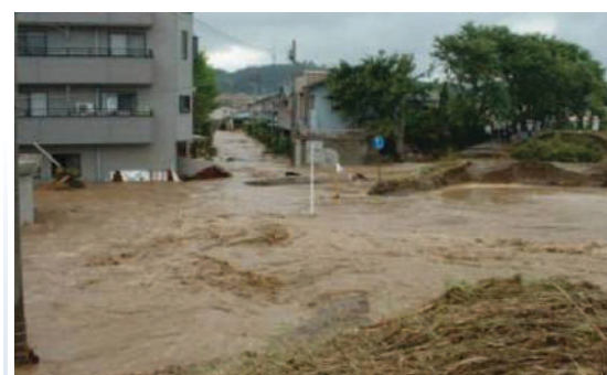
平成16年7月洪水(福井豪雨)足羽川の堤防が決壊(福井市春日)
