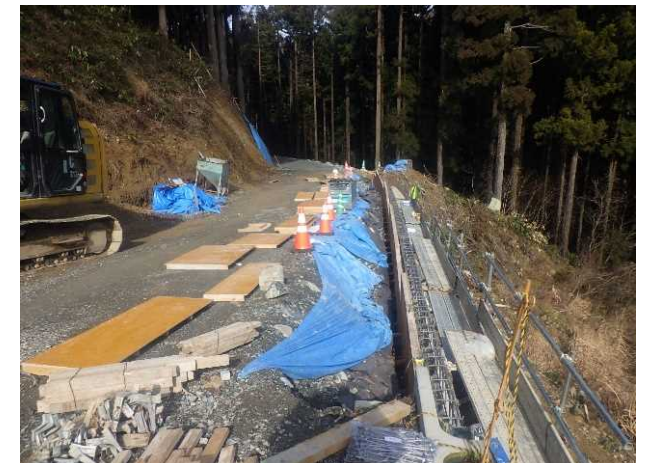
[11]付替町道広瀬千代谷線 千代谷2工区改良工事
