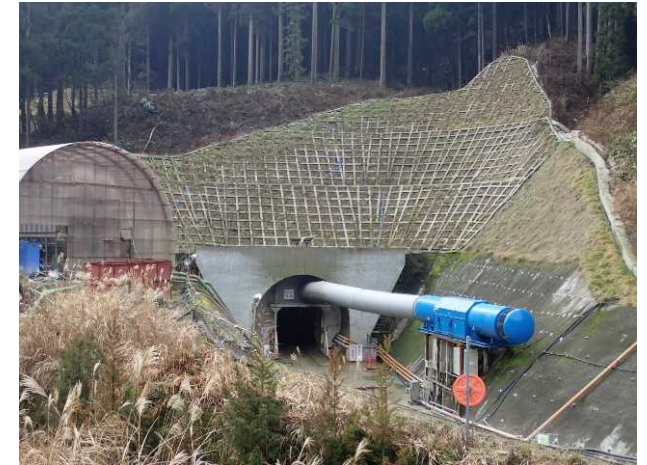
[5]水海川導水トンネル I 期工事
