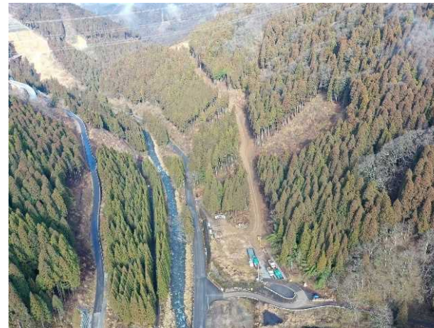
[13]足羽川ダム原石山掘削他工事
