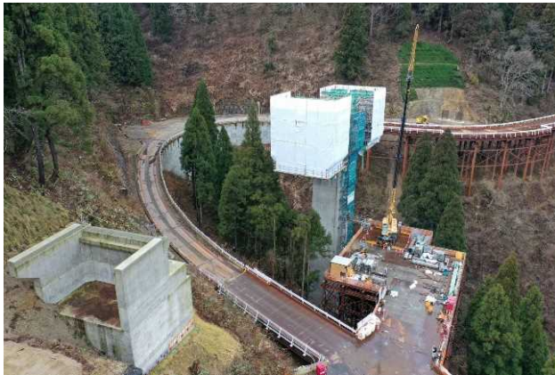
[8]付替県道7号橋上部工事
