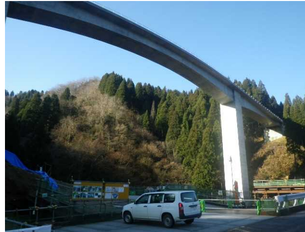
[3]付替県道8号橋工事
