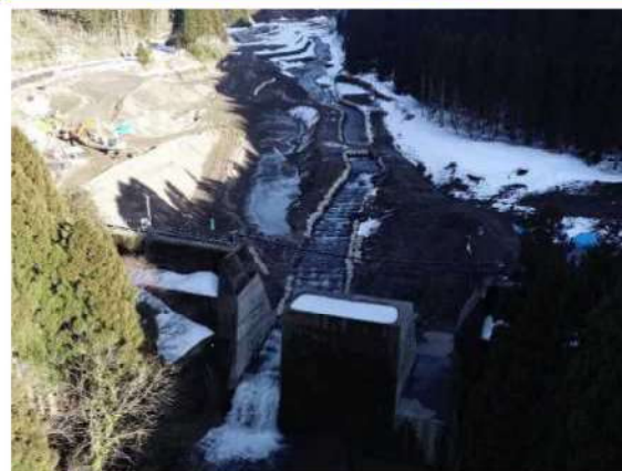
[7]水海川分水施設右岸河床 掘削他工事
