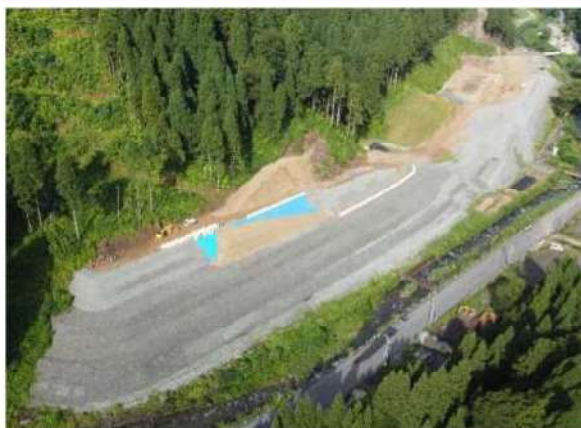
[34]足羽川ダム付替県道6工区 土工19改良工事
