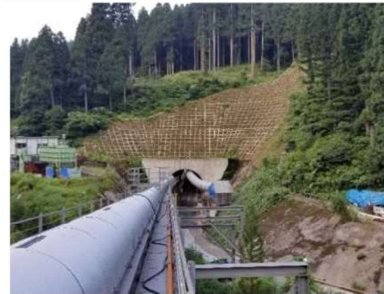
[6]水海川導水トンネル2期工事
