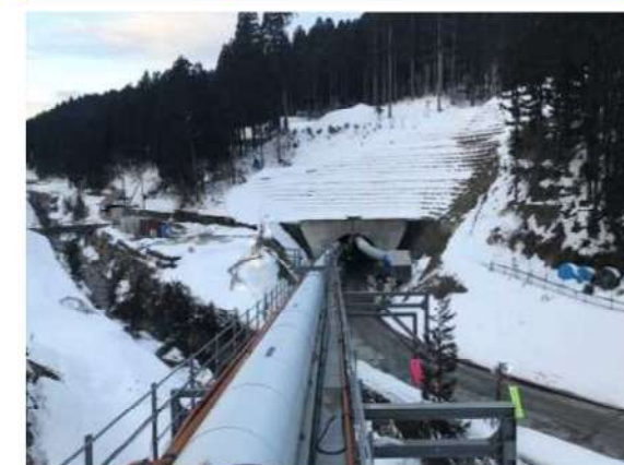
[6]水海川導水トンネル2期工事
