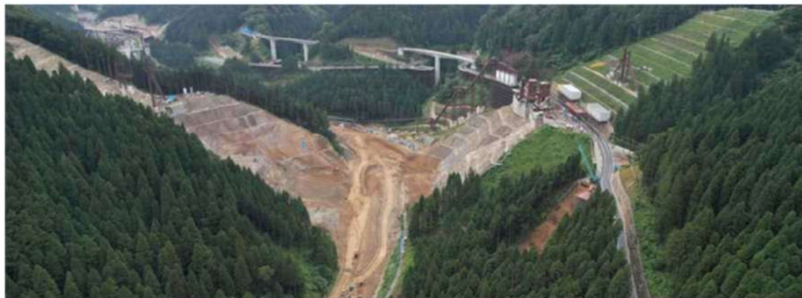
[4]足羽川ダム本体建設(第1期)工事
