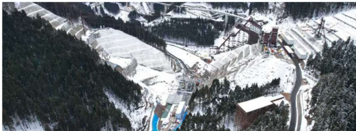
[4]足羽川ダム本体建設(第1期)工事
