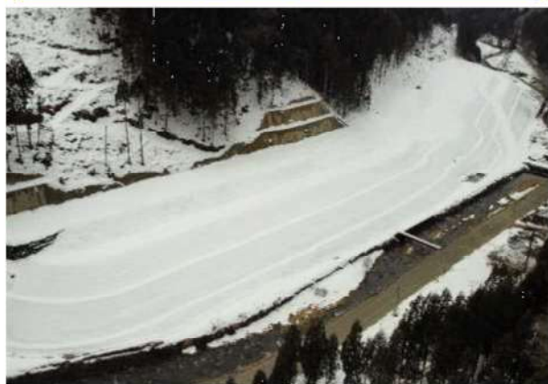
[33]足羽川ダム付替県道6工区 土工19改良工事
